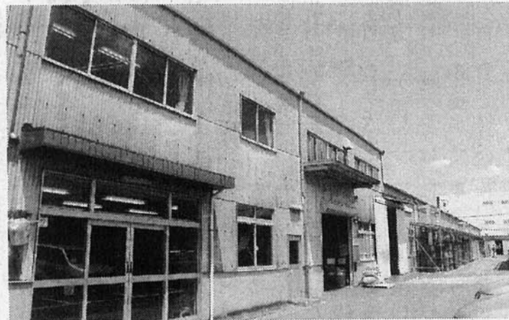
「保安重要部品」を中心に製造する鈴木化学工業所 (岡崎市福岡町)
